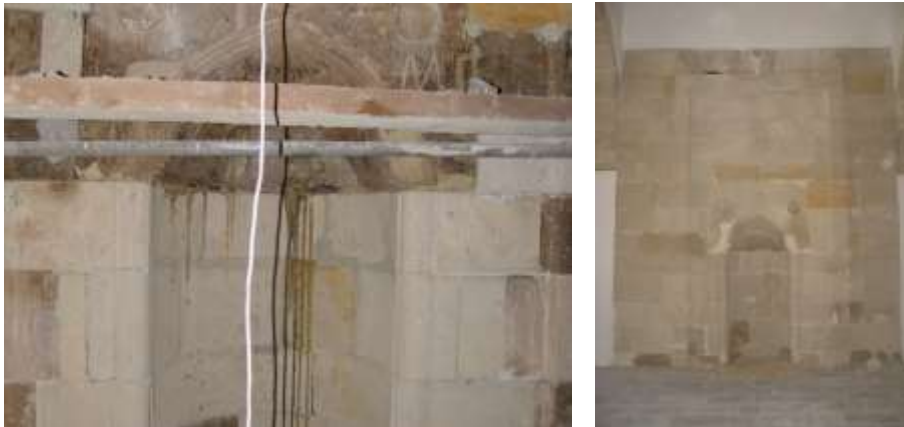
Şekil 11. Taş Beden Duvarlarında Rock Stop Enjeksiyon Uygulaması (Yeğin,2010)
