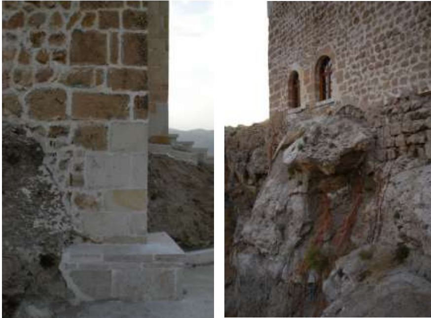
Şekil 10. Kale Cami Beden Duvarlarında Rock Stop Enjeksiyonu ve Tamamlama (Yeğin, 2010)
