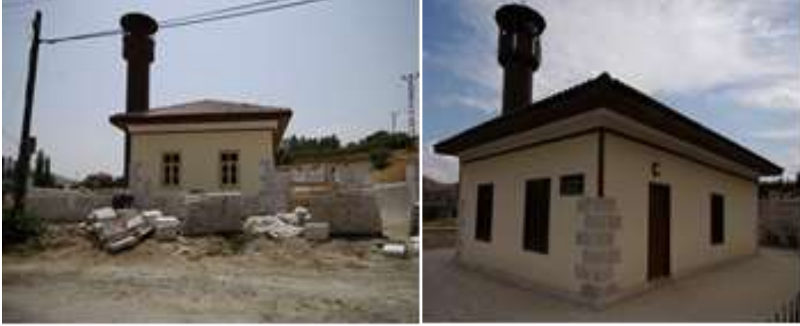
Şekil 9. Karamahmut Cami Rekonstrüksiyonu (taş ve kerpiç örgü, uygulaması)(Yeğin,2008)
