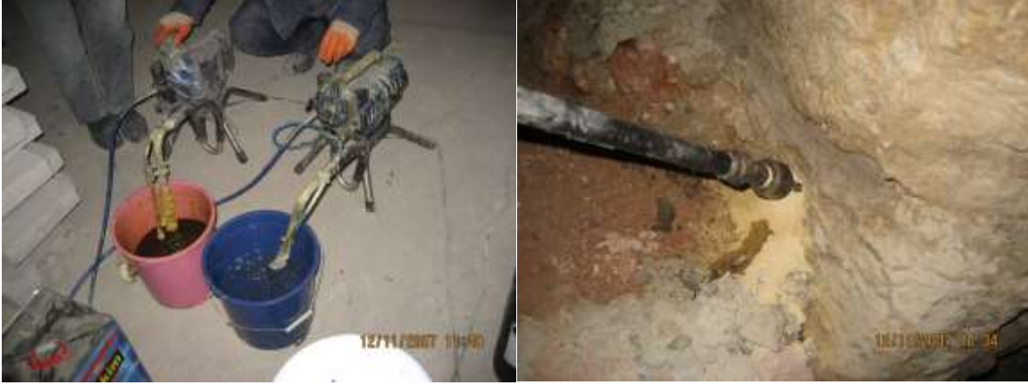
Şekil 1. Rock Stop Enjeksiyon Reçinesi Şekil 2. Rock Stop Enjeksiyonu (Yazar Arşivi)
