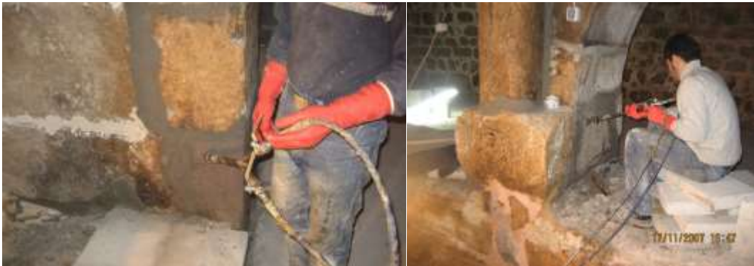
Şekil 3. Rock Stop Enjeksiyonu Uygulaması
