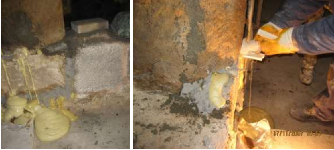
Şekil 5. Enjeksiyon Sonrası Piriz Alma Süreci (Yeğın, 2007)
