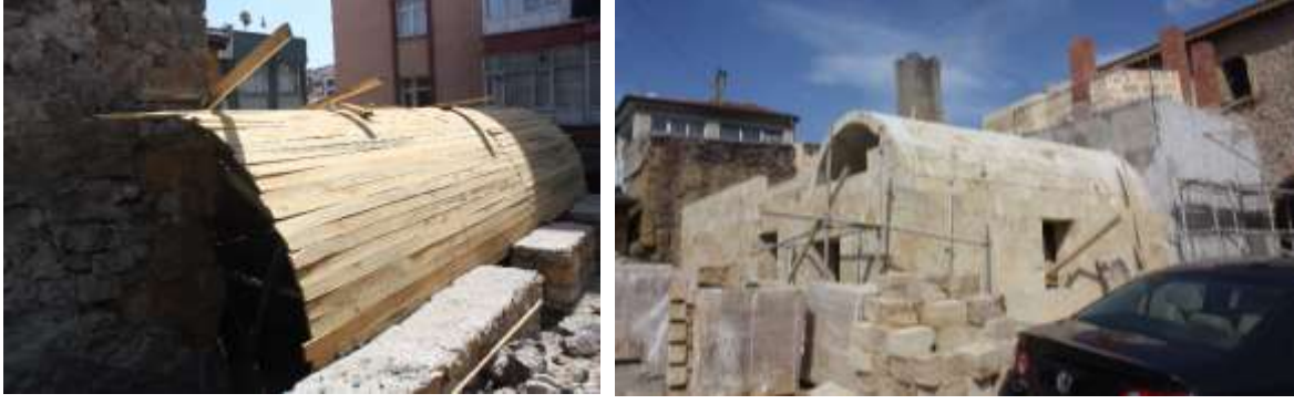
Şekil 12. Çapanoğlu Hamamı Taş Tonoz Rekonstrüksiyonu (Yeğın, 2013)
