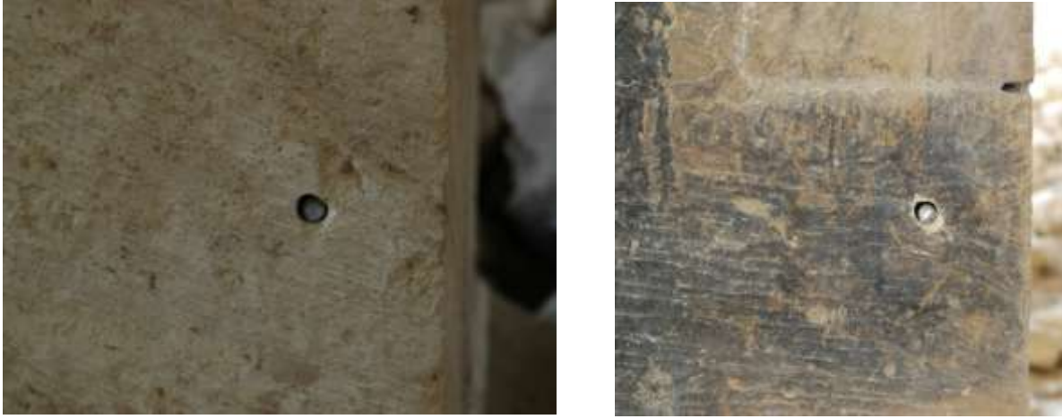
Şekil 6. Taş Ayaklarda Kimyazal Ankraj Yapımı (Yeğın, 2009)
